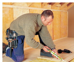
Pladerne skrues og limes til strøerne med strø-afstand op til 60 cm
