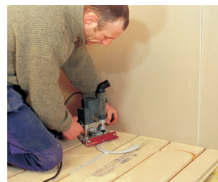
Man fræser selv sine vendespor i DLH Thermogulv
